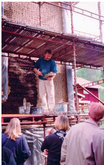
Ett byggnadsvårdskunnande utvecklades i Hälsingland under 1990-talet. Först med AMS hjälp, efterhand tog länets byggföretag över och blev riksskända för sitt kunnande, främst i timmerteknik. Här demonstreras revetering med lerbruk framgrävt på platsen av muraren Erik Andersson. År 2000. Foto: Erik Nordin
